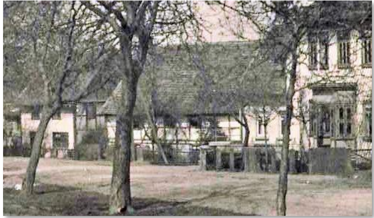
BLICK ÜBER DIE REICHSSTRASSE 6 AUF HAUS NO. 13 UM 1930 (BILDMITTE)
